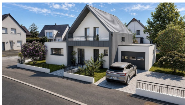
Façade sur rue et second accès
