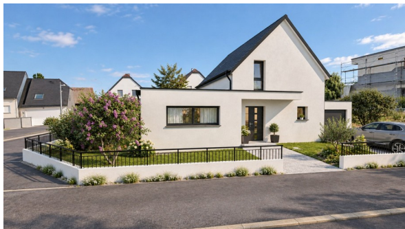
Façade sur rue et entrée
