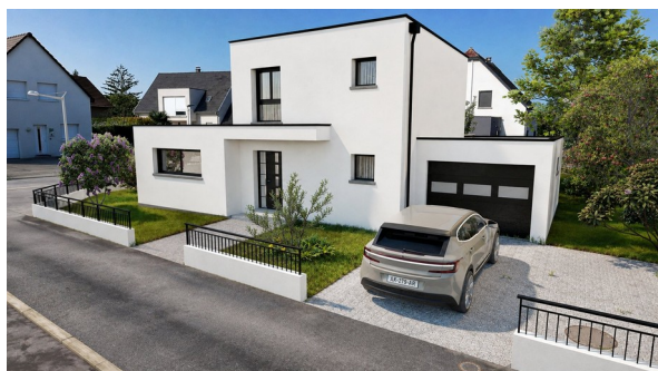
Façade sur rue et accès garage
