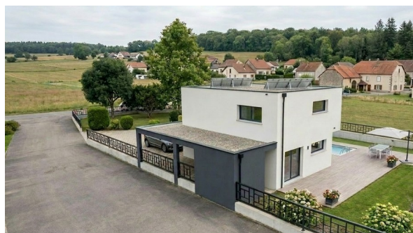
Le carport et la façade sur rue
